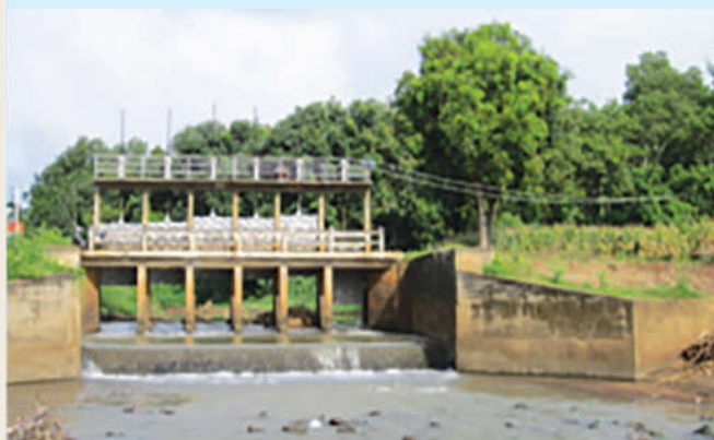
Công trình thủy lợi
