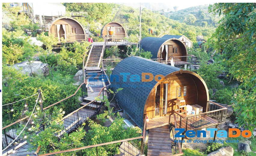
Mẫu nhà thông minh của anh Toàn tại khu du lịch sinh thái
